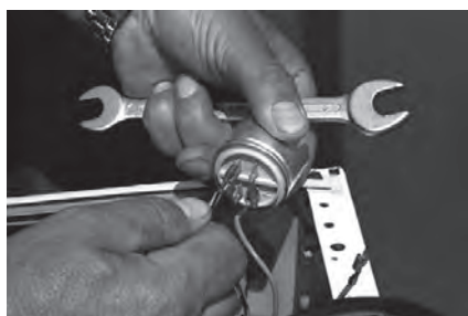
Ilustración 75: Sacar los cables del condensador. Foto: eag-leitfaden.
